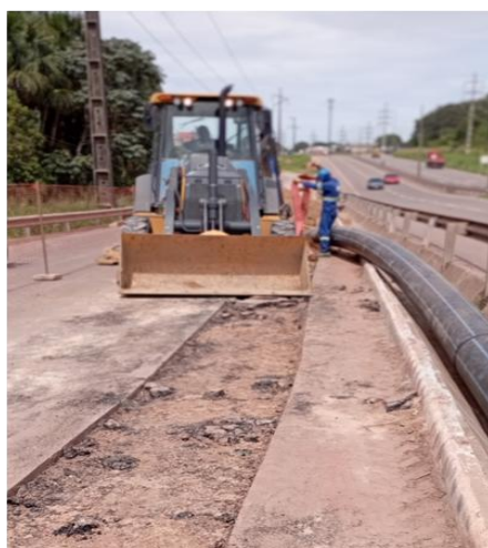
26 de Janeiro – Colocando adutora
